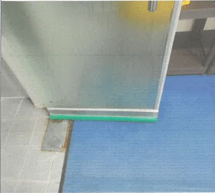
수영장 여자샤워실 계단쪽 강화문 하부 안전리부 부착
