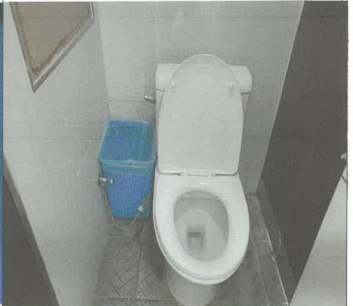
2층 여자화장실 변기 카바 고정
