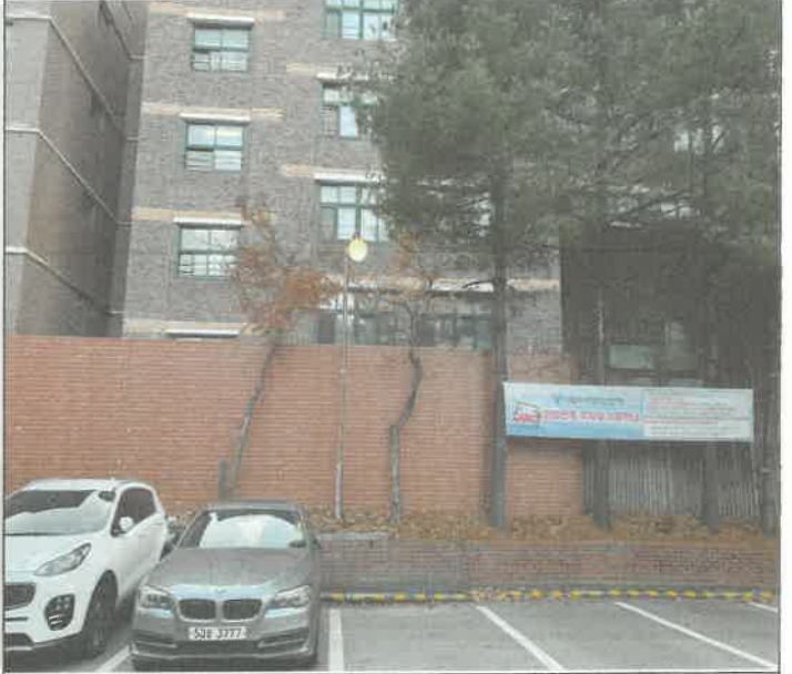
주차장 외등 1개소 전구교체
