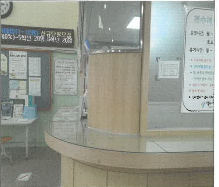
1층 수납 칸 막이 시공
