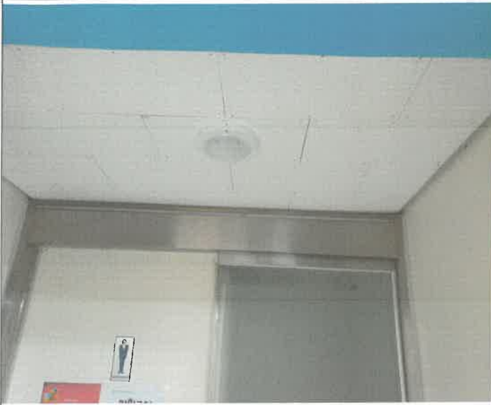
지하1층. 2층.3층 화장실 센서 등 교체
