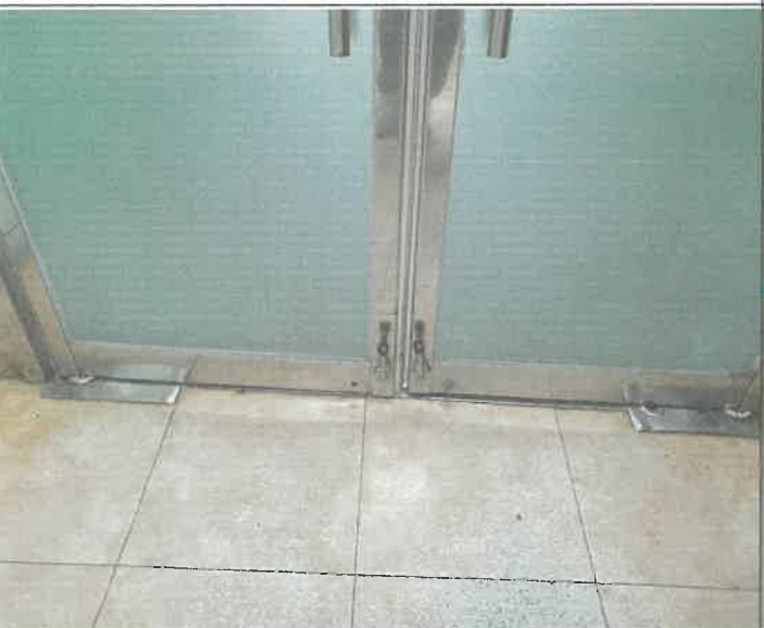
1층 주차장 출입구 출입문 도어 스토퍼 탈거 되어 제설치
