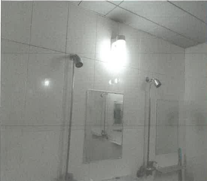
1층 대체육관 여자 샤워실 벽등 2개소 전구 교체
