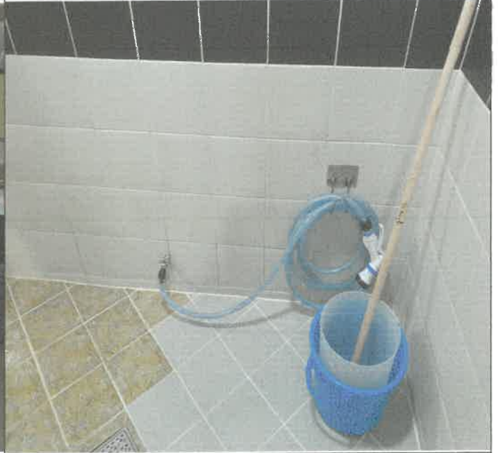
수영장 남자 샤워실 청소용 수도호수 노즐 교체
