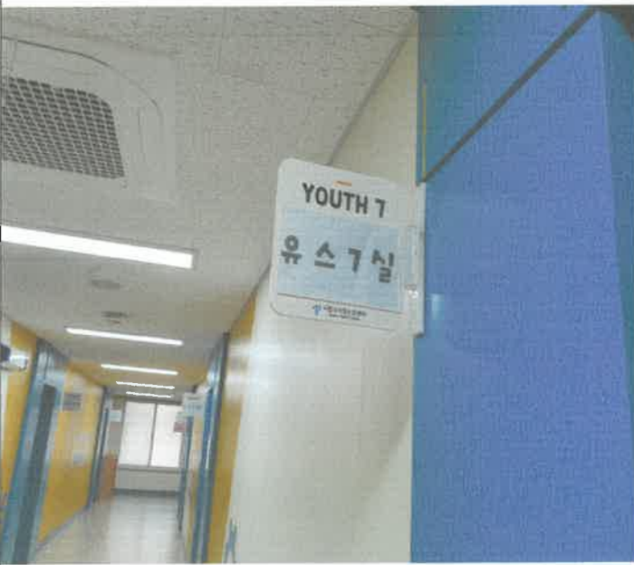
2층 유스 7실 명판 파손 수리 설치
