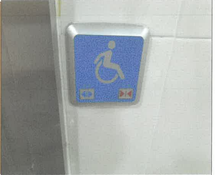
1층 여자 화장실 장애인 화장실 도어 스위치 건전지 교체
