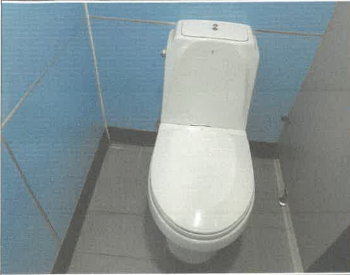
지하1층 남자 화장실 대변기 통수
