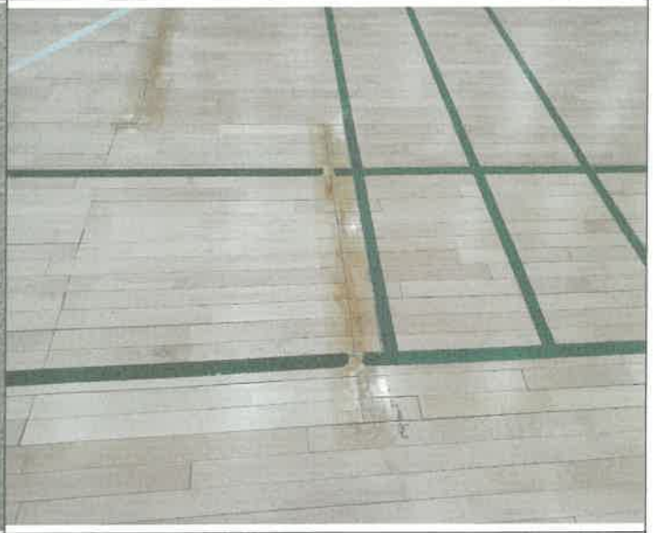
대체육관 마루 부분교체 개소 샌딩개소 니스 처리작업
