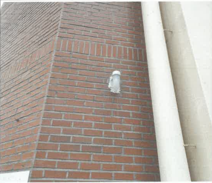
체육관 외벽 등기구 교체
