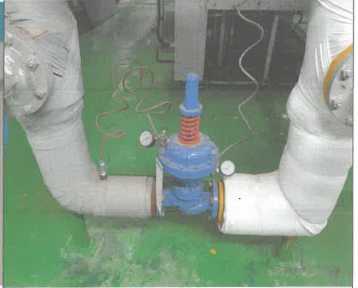
수영장 난방 차압밸브 스프링들 볼트조절
