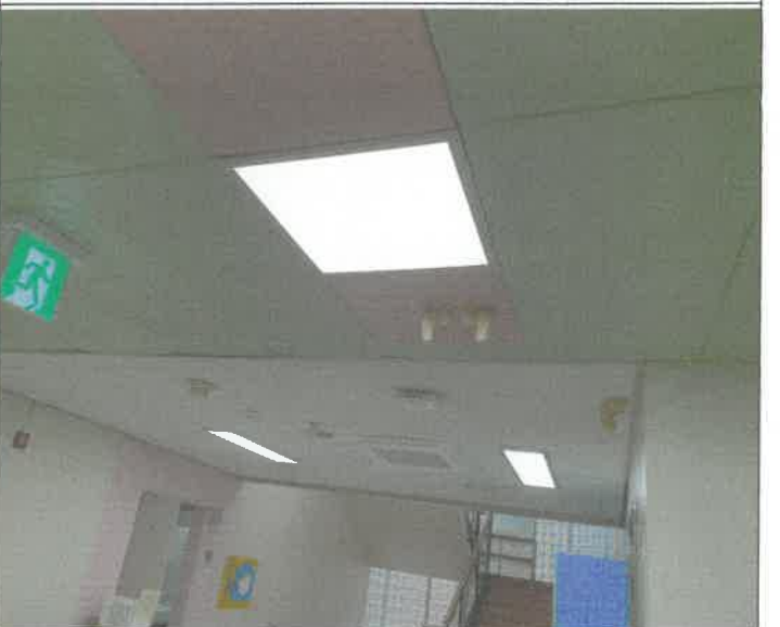
3층 중앙 복도 사각등 안전기 1개소 교체
