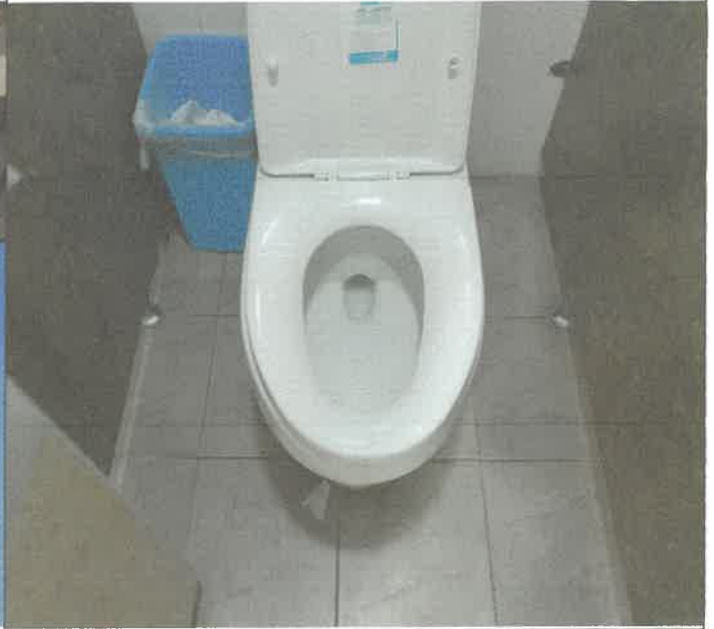
1층 여자 화장실 대변기 통수
